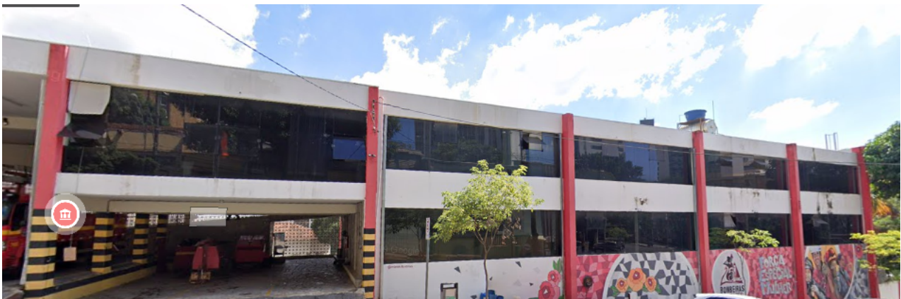
Imagem 01 - foto panorâmica da frente do quartel
